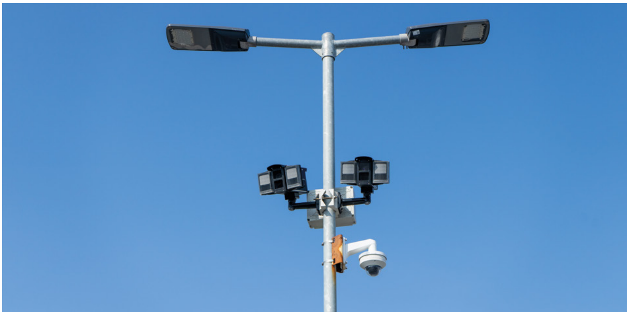
Abbildung 4: Mit Überkopfsensoren können mehrere Parkplätze gleichzeitig überwacht werden Quelle: Gary L Hider – stock.adobe.com
