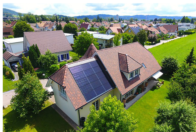
Bild einer Dachintegrierten Solaranlage www.kunz-solartech.ch
